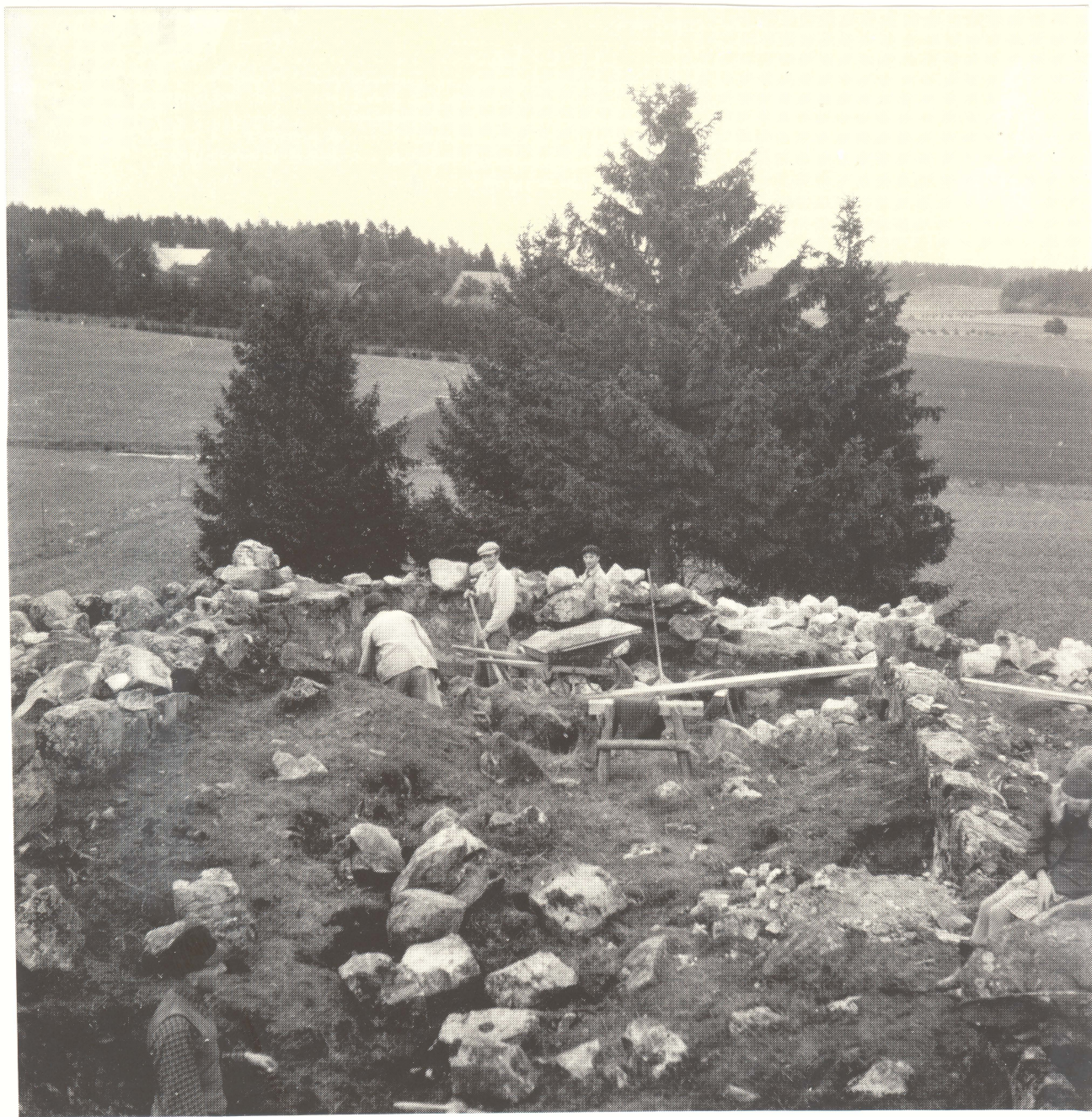
Här har restaureringsarbetena börjat.
