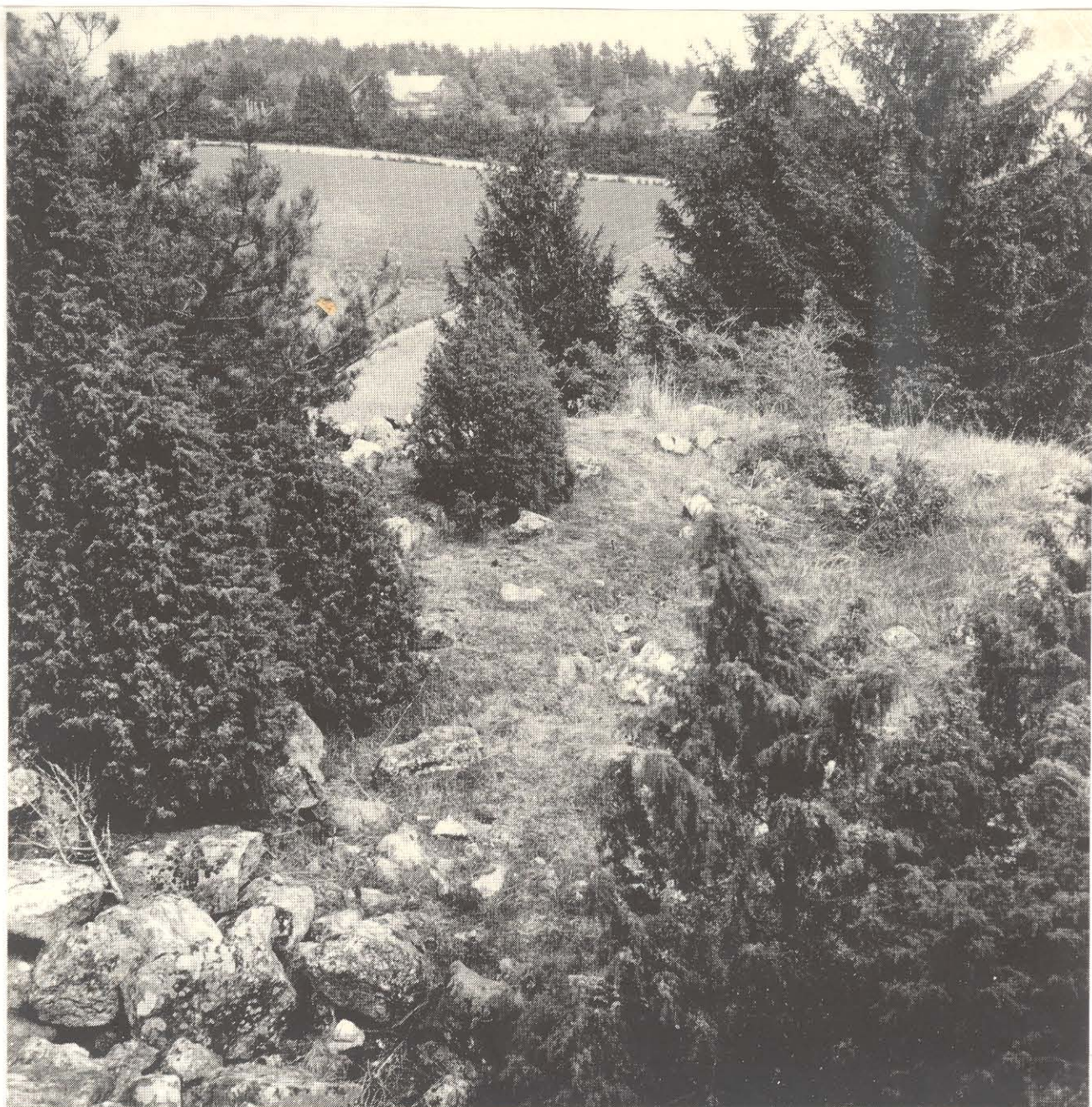
Så här såg kyrkoruinen ut före arbetets början med konservering i början av 1940-talet
