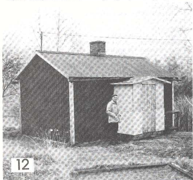
Alfons utanför tandläkarmottagningen på Lustigtorp.
