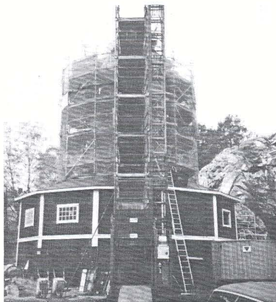
“Ettans“ kalkugn under renovering
