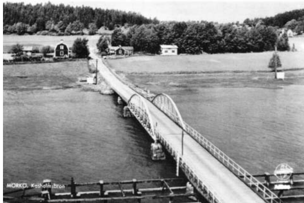
Mörköbron (Kasholmsbron) byggd 1912
